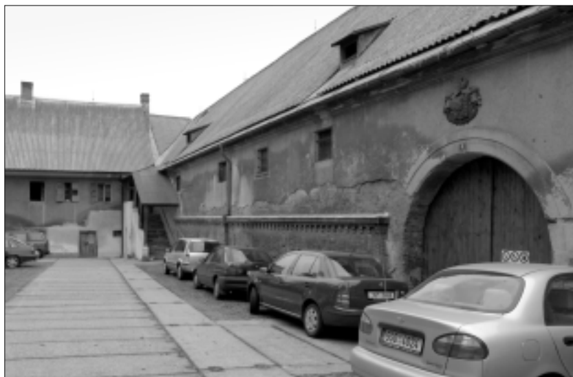
Obr. 6. Objekt A1 (vlevo) a A2, průjezd s knížecím znakem (před rekonstrukcí)
