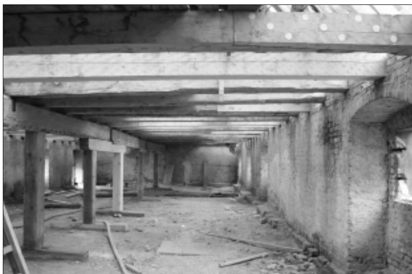
Obr. 10. Oprava dřevěných konstrukcí v objektu A2
