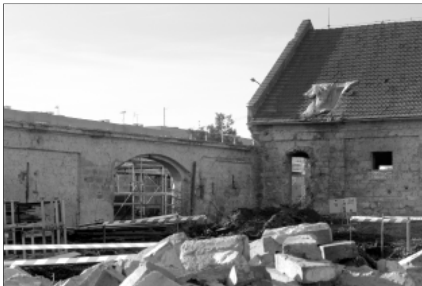
Obr. 18. Z rekonstrukce budov C2 (bez krovu a stropu) a C1
