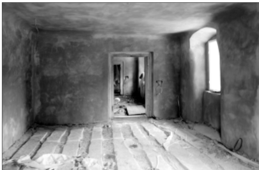
Obr. 12. Vnitřní prostory muzea řepařství v objektu A1
