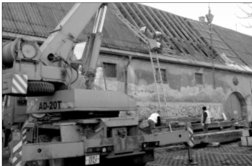
Obr. 8. Manipulace s historickými trámy z objektu A2
