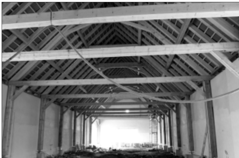
Obr. 16. Replika dobového krovu objektu C2
