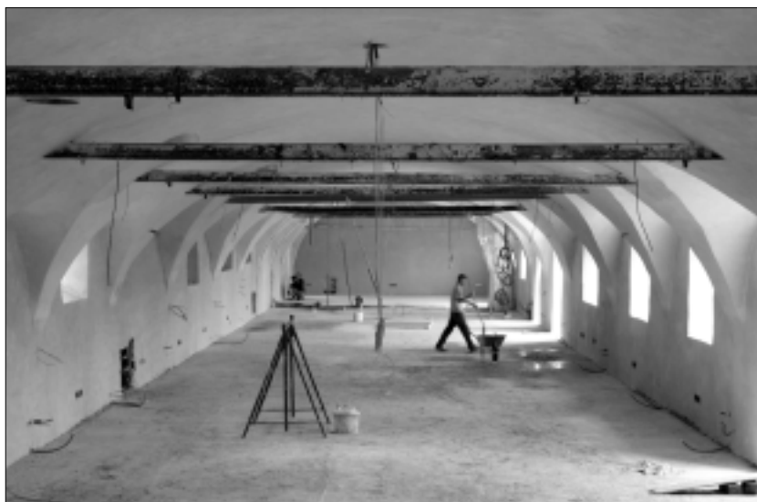
Obr. 11. Vnitřní prostory objektu A2, hlavní vstup do muzea
