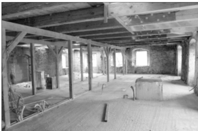
Obr. 7. Objekt A2 – administrativní zázemí společnosti
