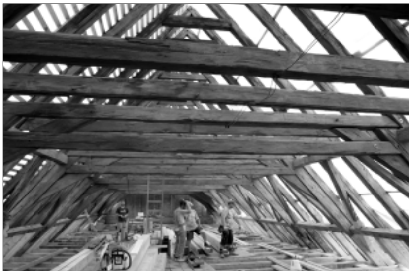
Obr. 9. Oprava renesančního krovu na budově A2
