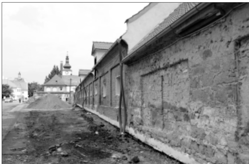
Obr. 15. Budovy C1 a C2 (muzeum cukrovarnictví, lihovarnictví), sanace zdiva
