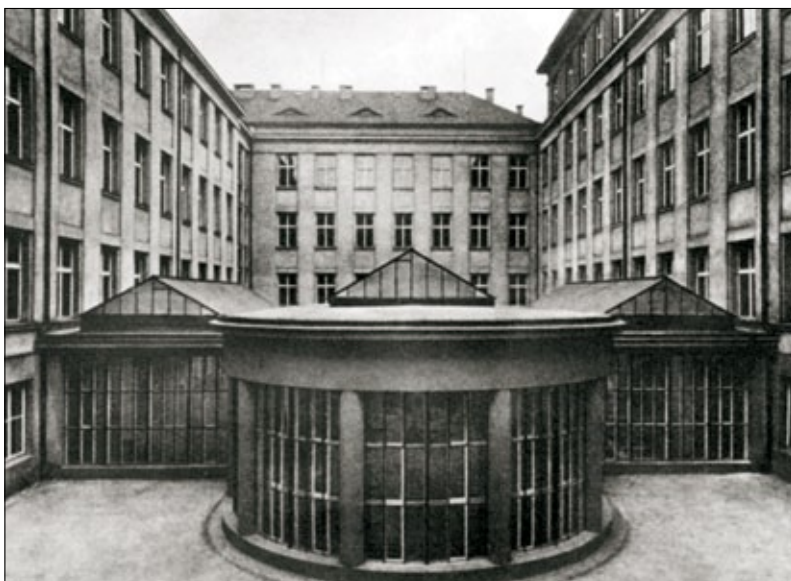
Obr. 9. Bývalé cukrovarnické muzeum ve dvoraně dnešní A-budovy VŠCHT
