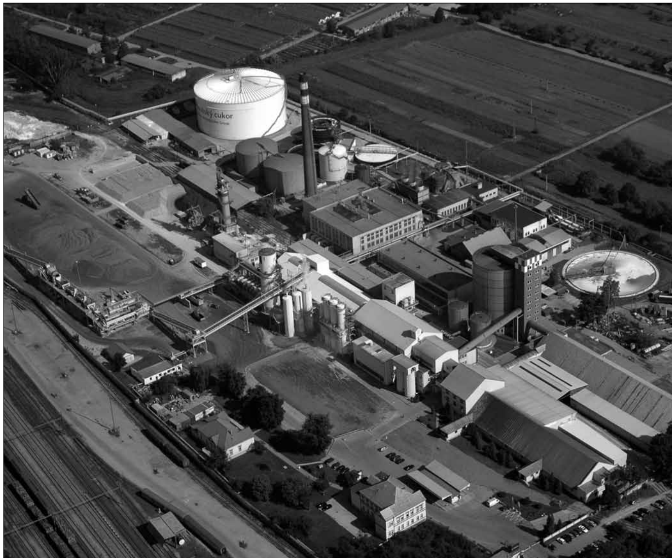
Obr. 4. Letecký pohľad na cukrovar po rekonštrukcii
