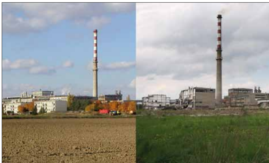
Obr. 4. Cukrovar na podzim 2006 (vlevo) a v průběhu demolice (vpravo)
