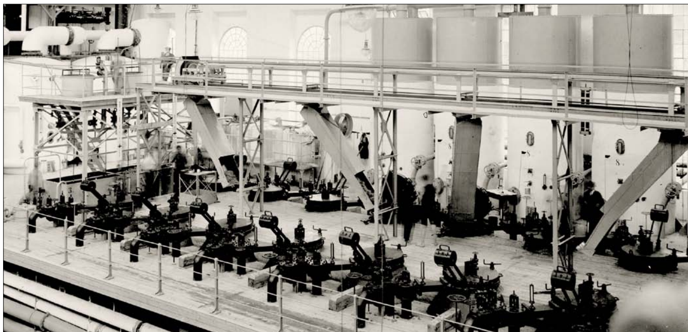
Obr. 1. Celkový pohled na vrchní část baterie Robertových difuzérů v cukrovaru Zvoleněves (1922)
