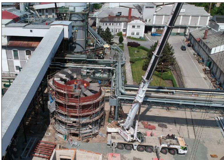
Obr. 3. Extraktor BMA – postupná instalace jednotlivých prstenců zařízení
