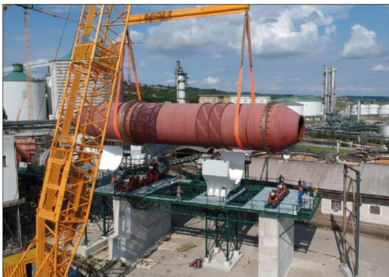
Obr. 2. Usazování bubnu pračky řepy
