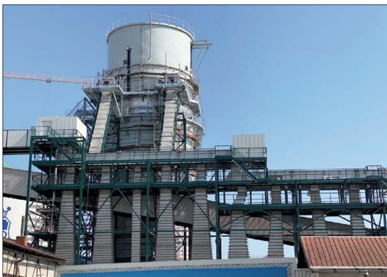
Obr. 4. Aktuální pohled na extraktor BMA včetně násypky k řízkolisům
