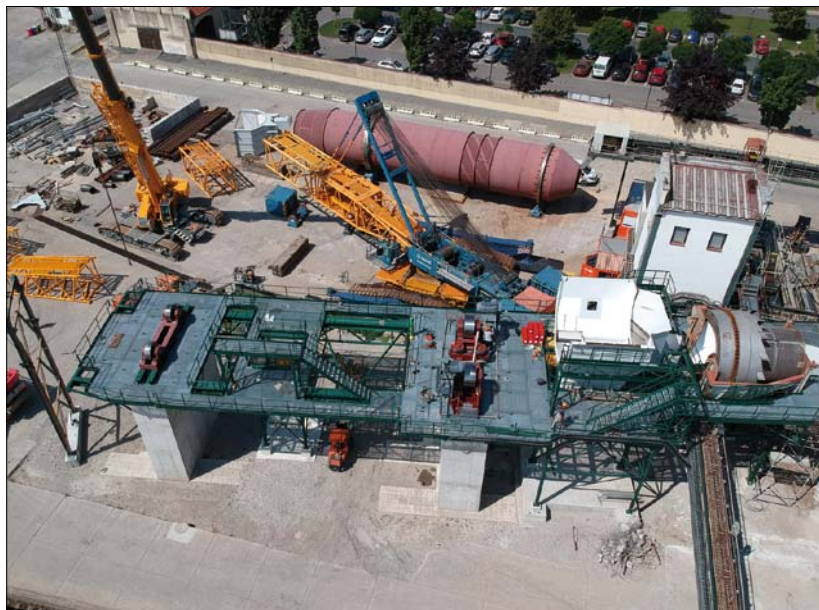
Obr. 1. Příprava na usazení nové bubnové pračky Maguin
