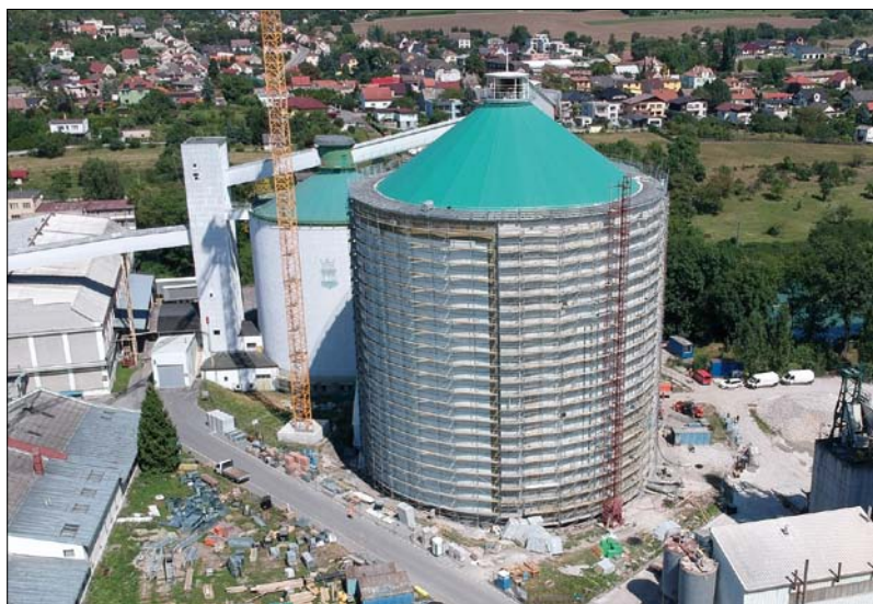
Obr. 4. Dokončené betonování a nová střecha sila
