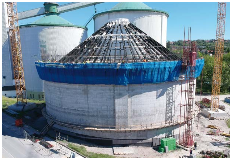
Obr. 3. Průběh kontinuálního betonování sila
