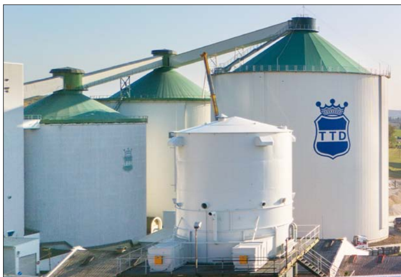
Obr. 5. Všechna tři cukerná sila dobrovického cukrovaru – staré na 20 000 a 30 000 t cukru s nově dokončeným na 50 000 t cukru
