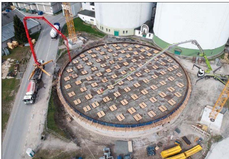
Obr. 1. Betonování podlahy nového sila v Dobrovice na 50 tis. t cukru
