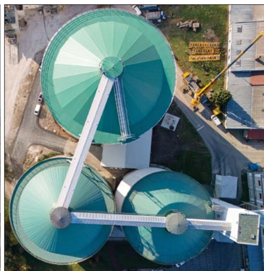
Obr. 5. Všechna tři cukerná sila dobrovického cukrovaru – staré na 20 000 a 30 000 t cukru s nově dokončeným na 50 000 t cukru
