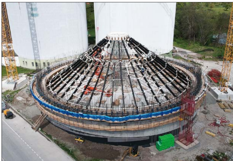
Obr. 2. Konstrukce střechy sila připraveného na betonování
